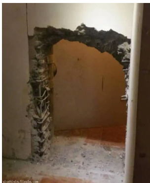
拆改混凝土承重墙
