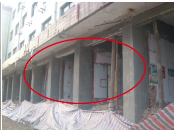
拆首层墙、改建为框架
