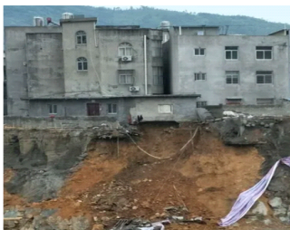
临近未支护的基坑
