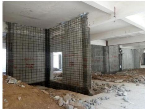
剪力墙加固示意图（增大截面加固法）
