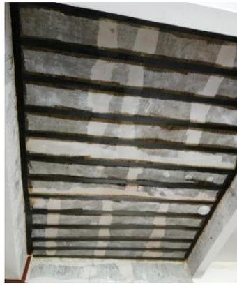
混凝土板加固示意图（粘贴碳纤维加固法）
