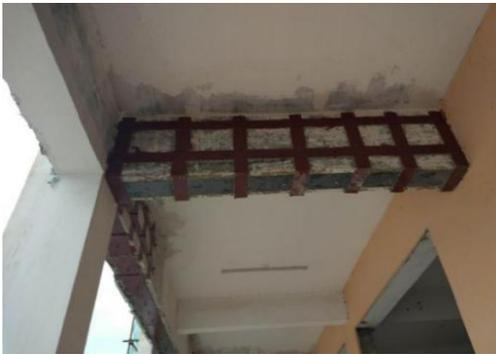
混凝土梁加固示意图（粘贴钢板加固法）
