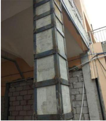
混凝土柱加固示意图（外粘型钢加固法）
