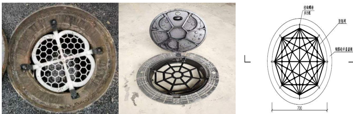
图 2.13 防坠落装置示意图
