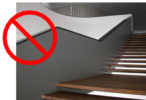
图3.5.7-2 不应采用无筋砖砌栏板
