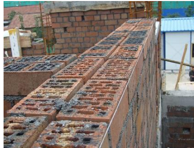
图3.5.2-3 烧结多孔砖墙
