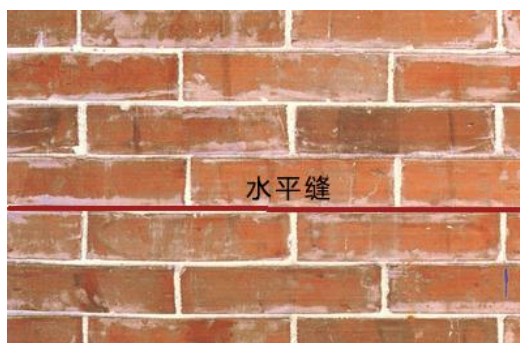
图 5.2.4 水平灰缝
