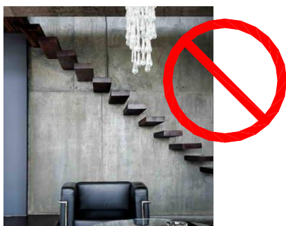
图3.5.7-1 不应采用墙中悬挑式踏步
